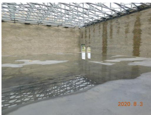
Gym floor concrete pour is complete
