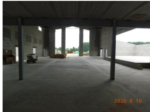
Student dining area concrete floor pour complete
