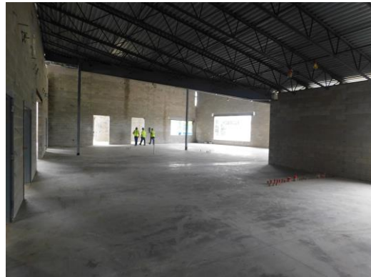
Media center concrete pour is complete
