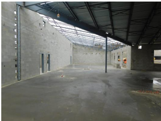
Admin area concrete pour is complete
