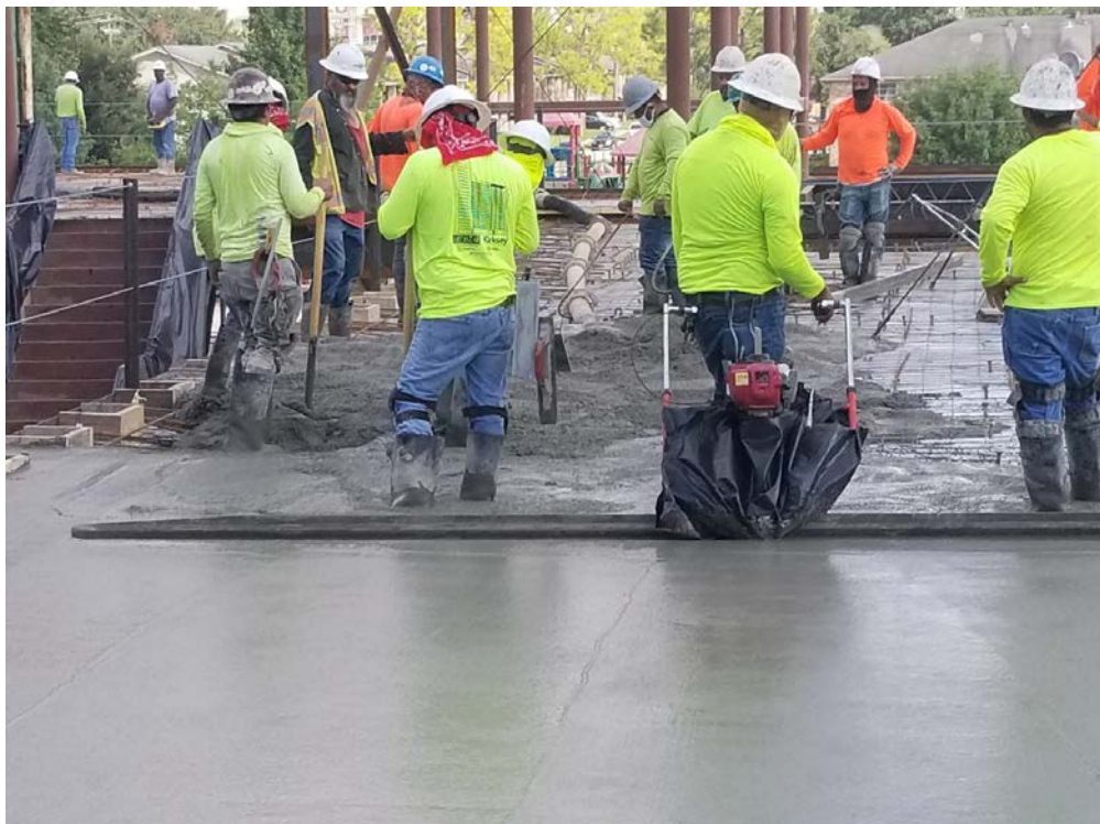
Pouring 2 nd Floor Slab
