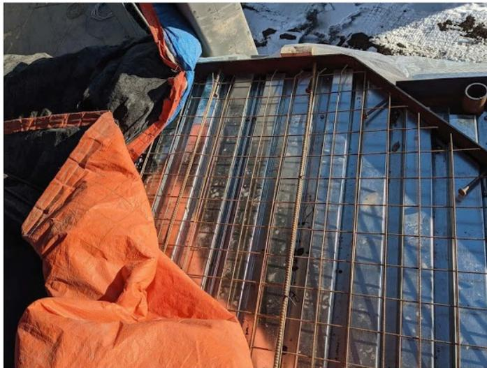
IMAGE 2: STEEL REINFORCING AT CANTILEVER EDGE
