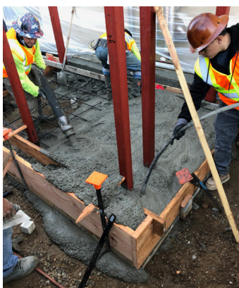
Derramando concreto para el aire acondicionado en la Escuela Primaria Alvarado
