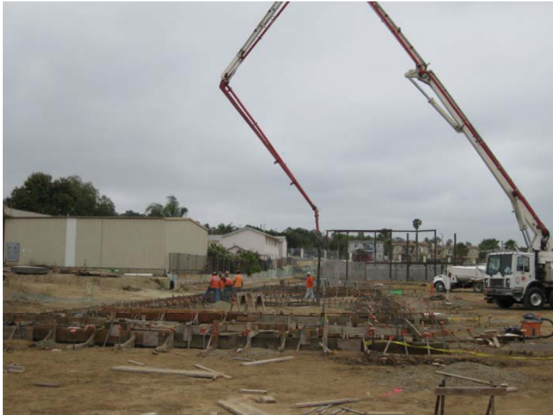
Building C Foundation Pour
