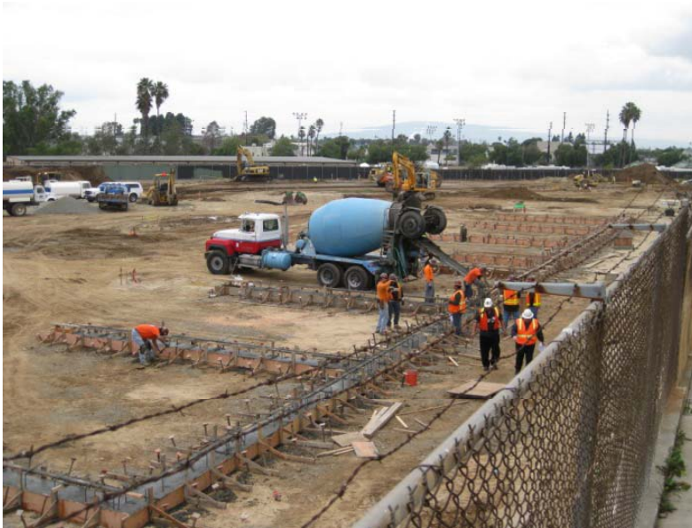
Spread Footing Pour
