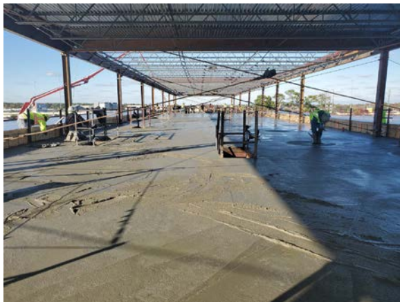
Level 5 mechanical penthouse slab pour
