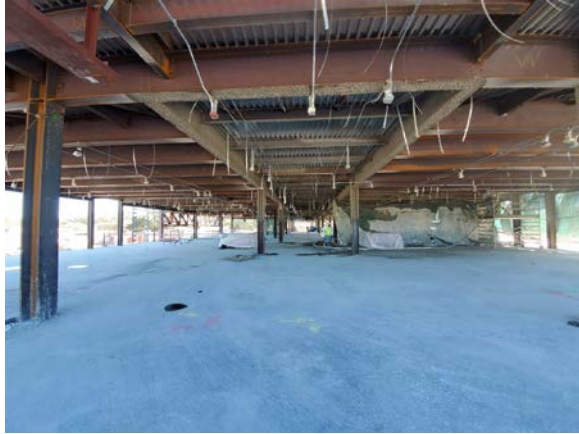
Level 3 after concrete pour
