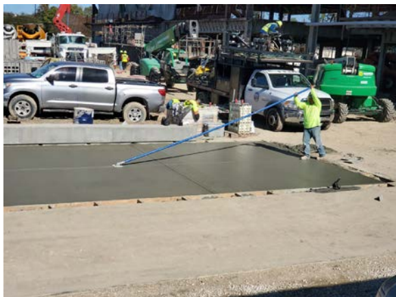
Plaza paving pour
