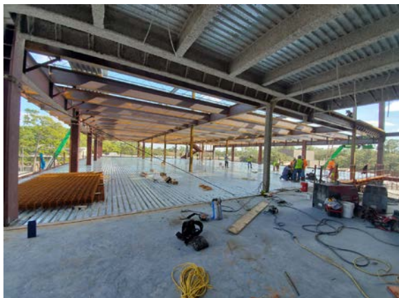
Area NC3 deck pour prep
