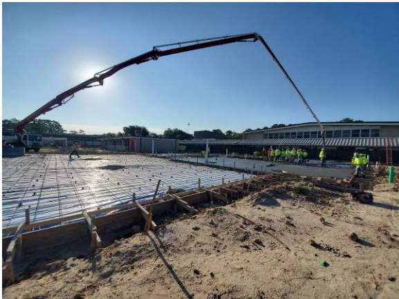
Area B Slab Pour
