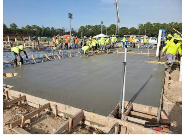
Area A Slab Pour
