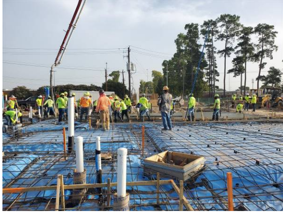
Area A Slab Pour
