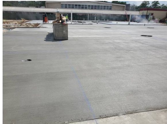
Area B Slab Pour
