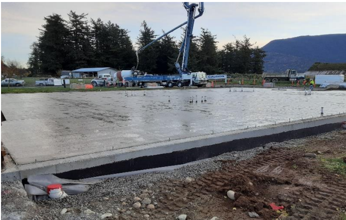
8:00 a.m.: Concrete pour complete.
