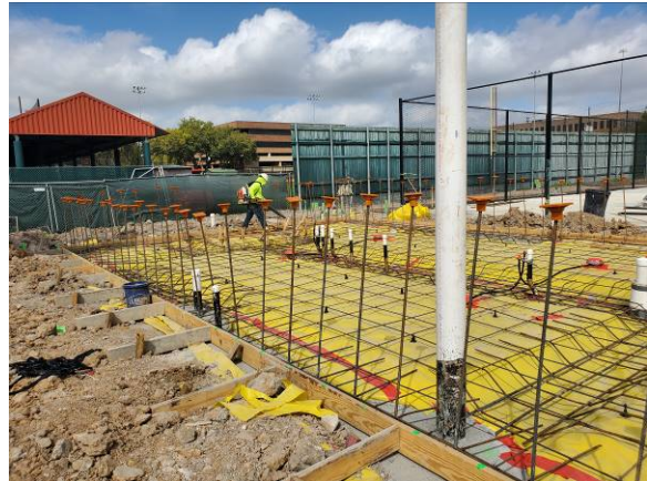
Tennis Field House Slab Pour
