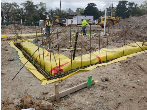
Tennis Field House Grade Beam Pour
