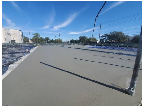
Tennis Court concrete pour
