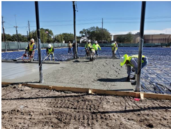
Tennis court concrete pour
