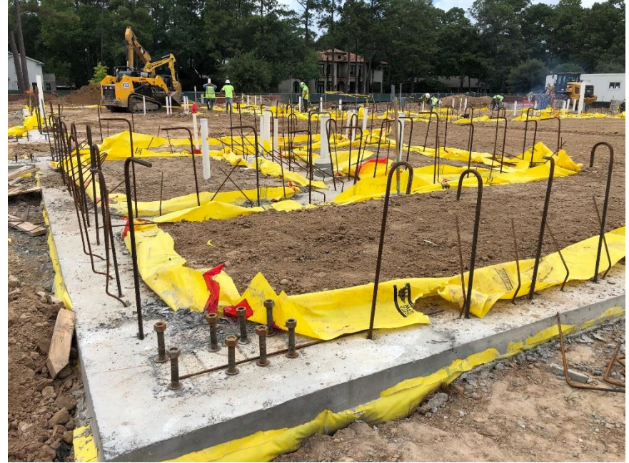
Area F - Pouring beams
