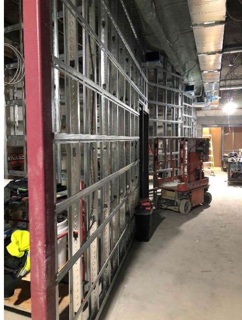
SFHS Area F metal stud walls
