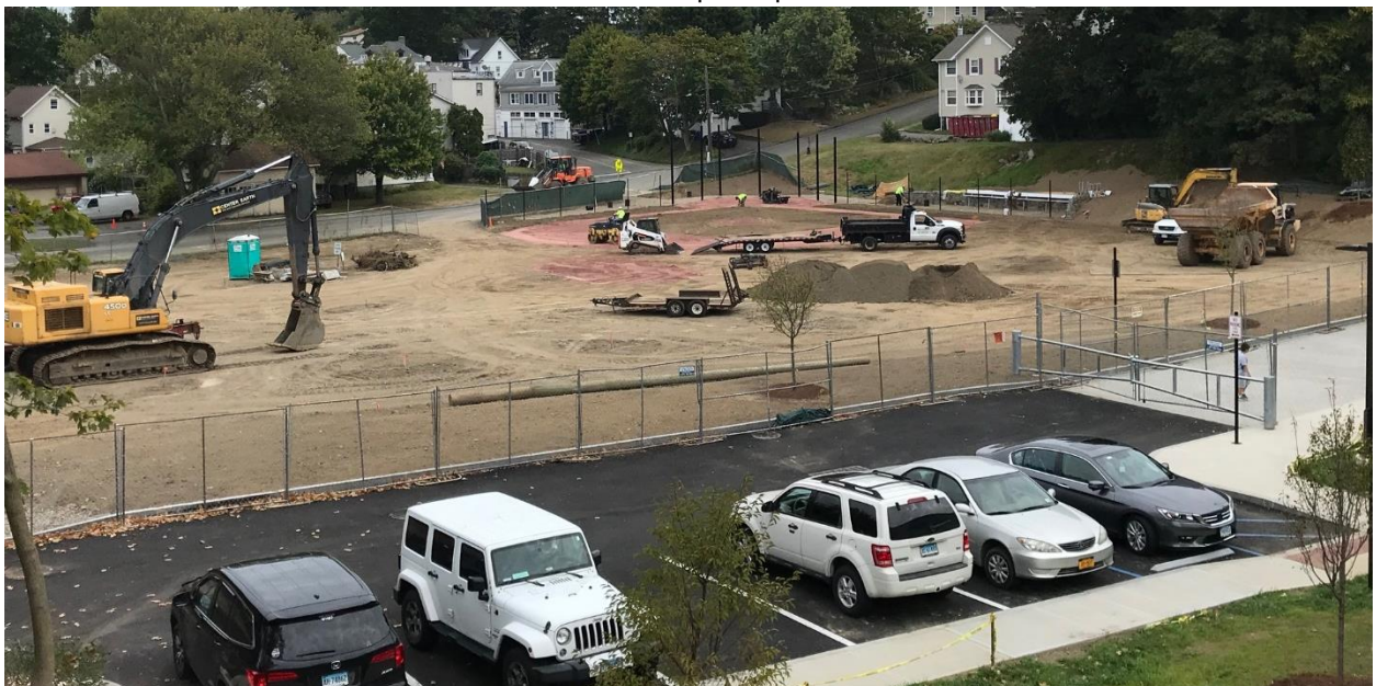
Reconstrucción del campo deportivo - 2-10-19
