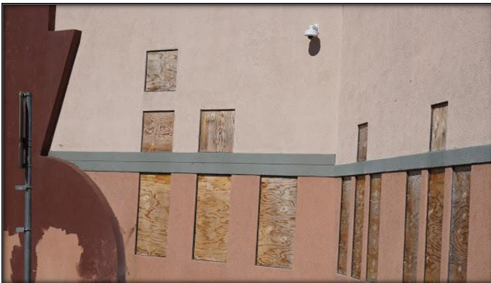
Figura 5: Todavía hay trabajo pendiente en el edificio multiusos de Mathson
