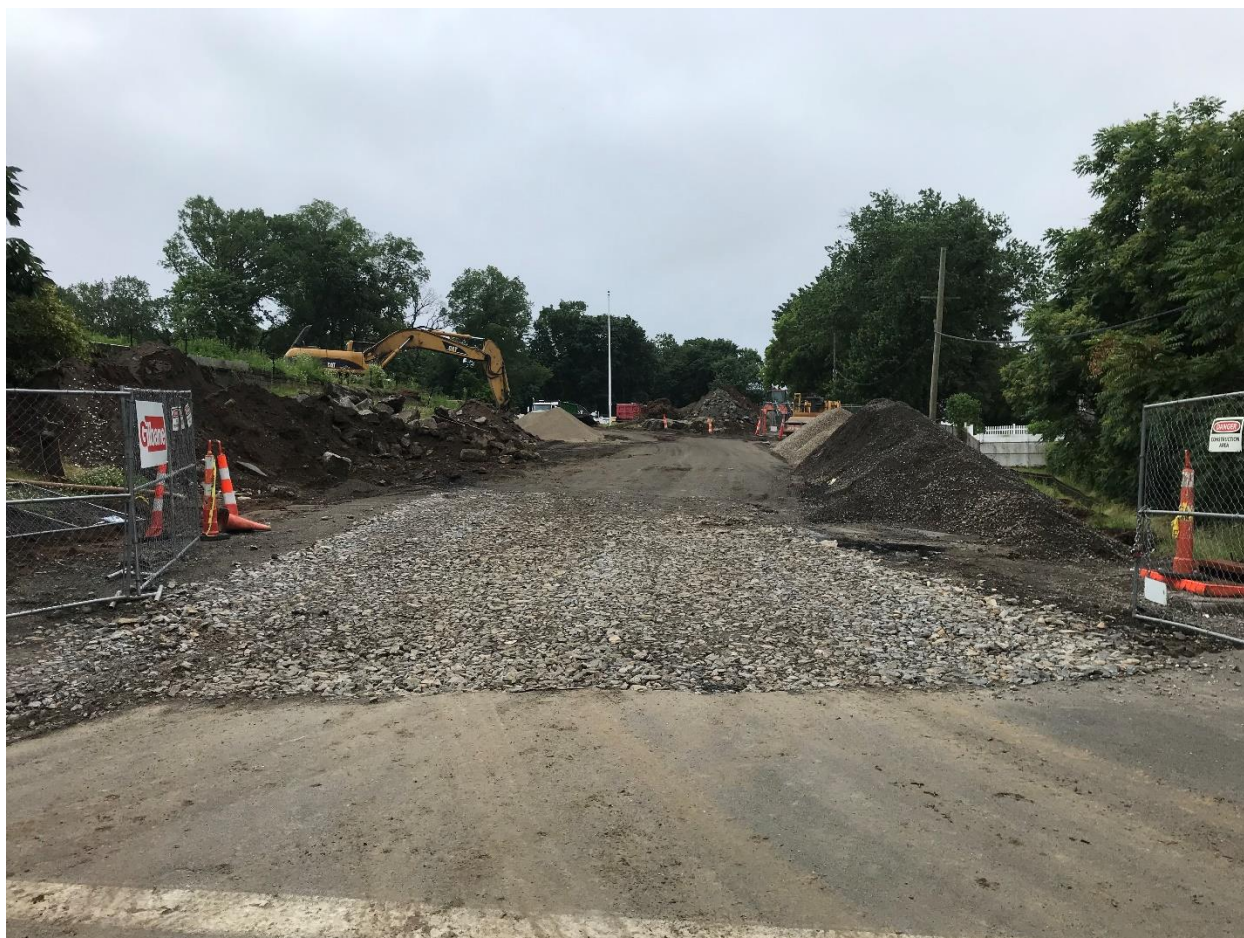
Construcción de la Entrada – 6/19/19
