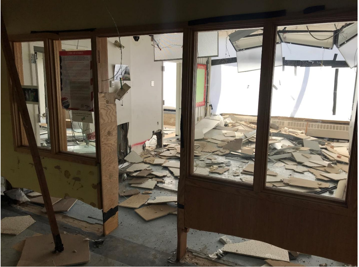
Eliminación de la oficina principal – 24-4-19
