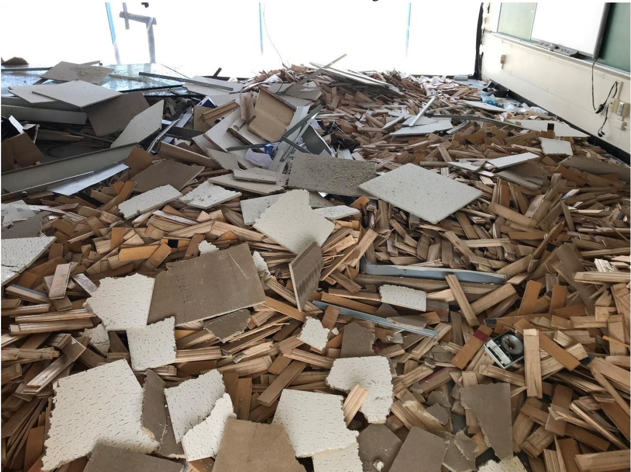
Eliminación del material del suelo del gimnasio – 24-4-19
