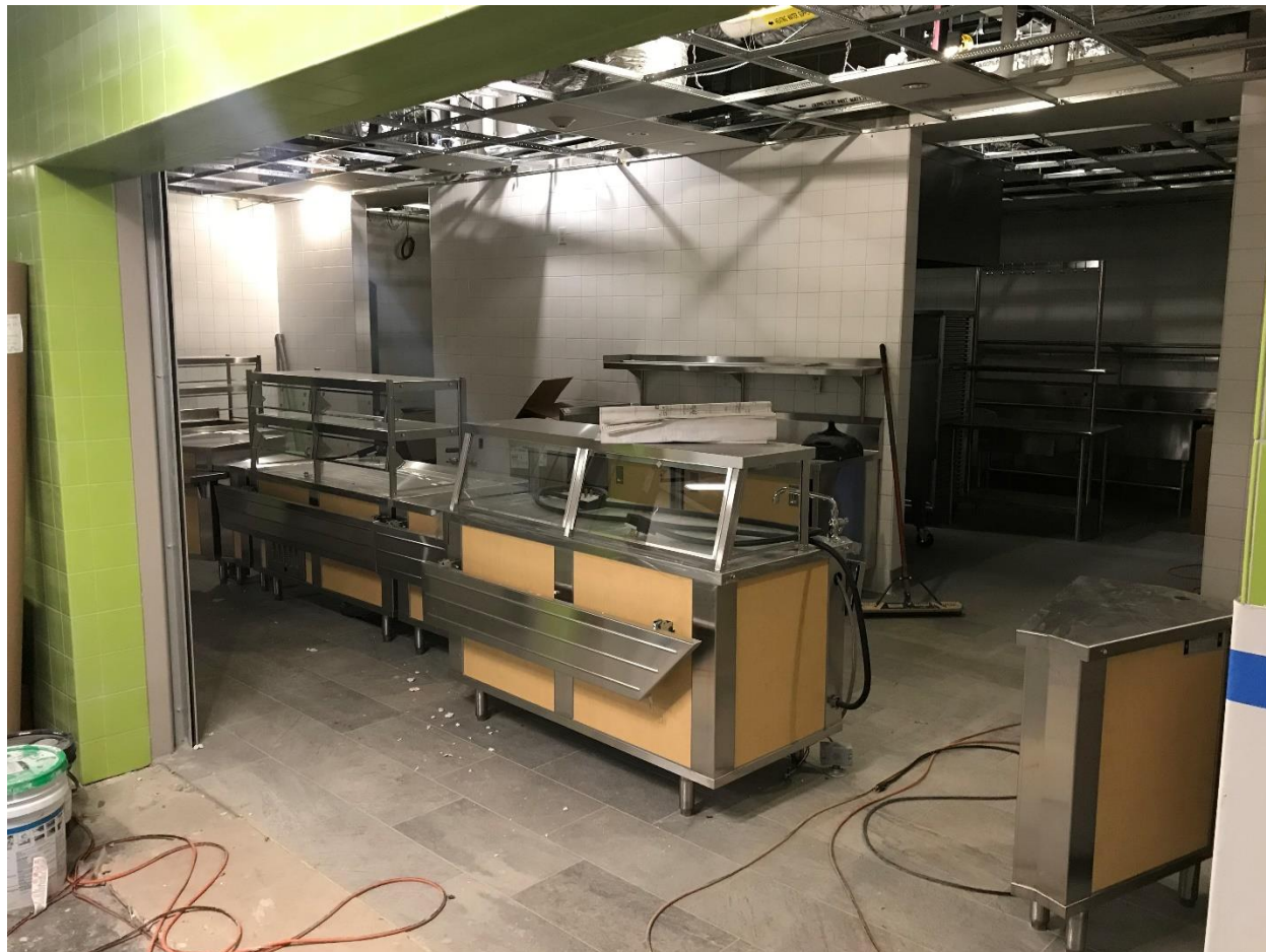
Mostradores de la cocina – 29 de enero de 2019
