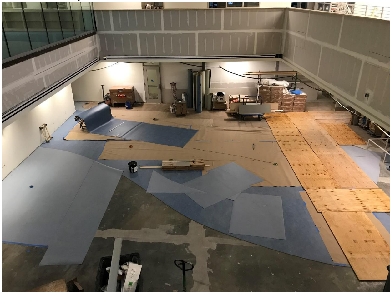
Disposición de la cafetería e instalación del suelo – 29 de enero de 2019
