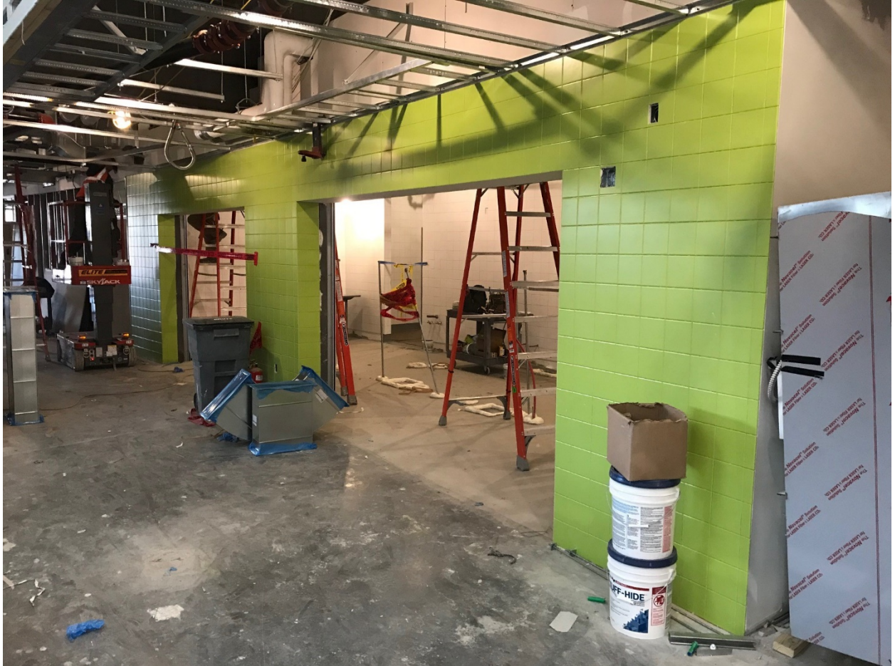
Cocina en progreso – 12-19-18
