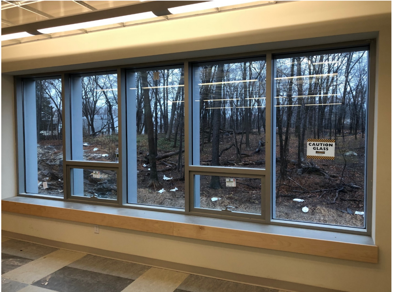
Acabado en las aulas – 28-12-18
