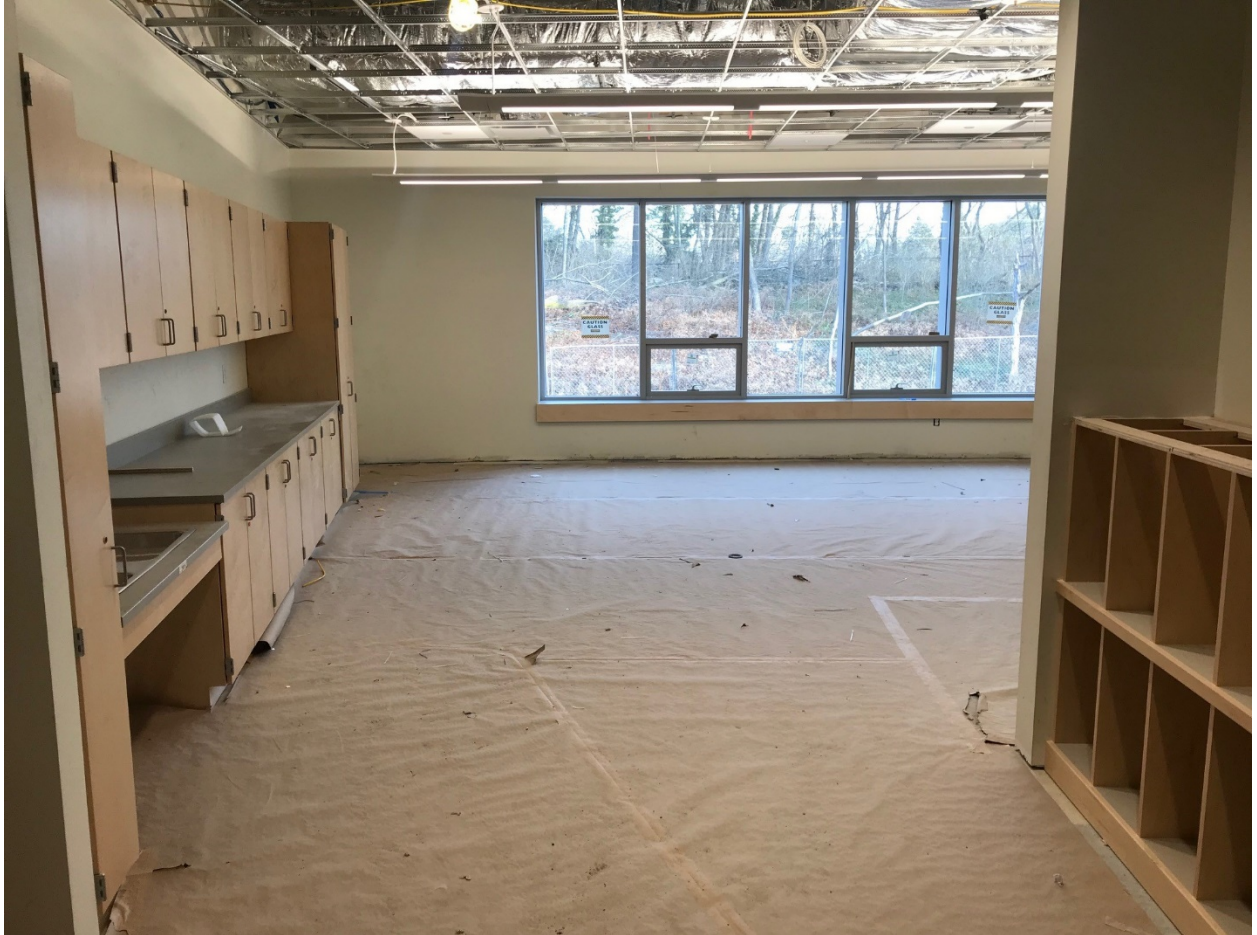
Acabado en las aulas – 19-12-18
