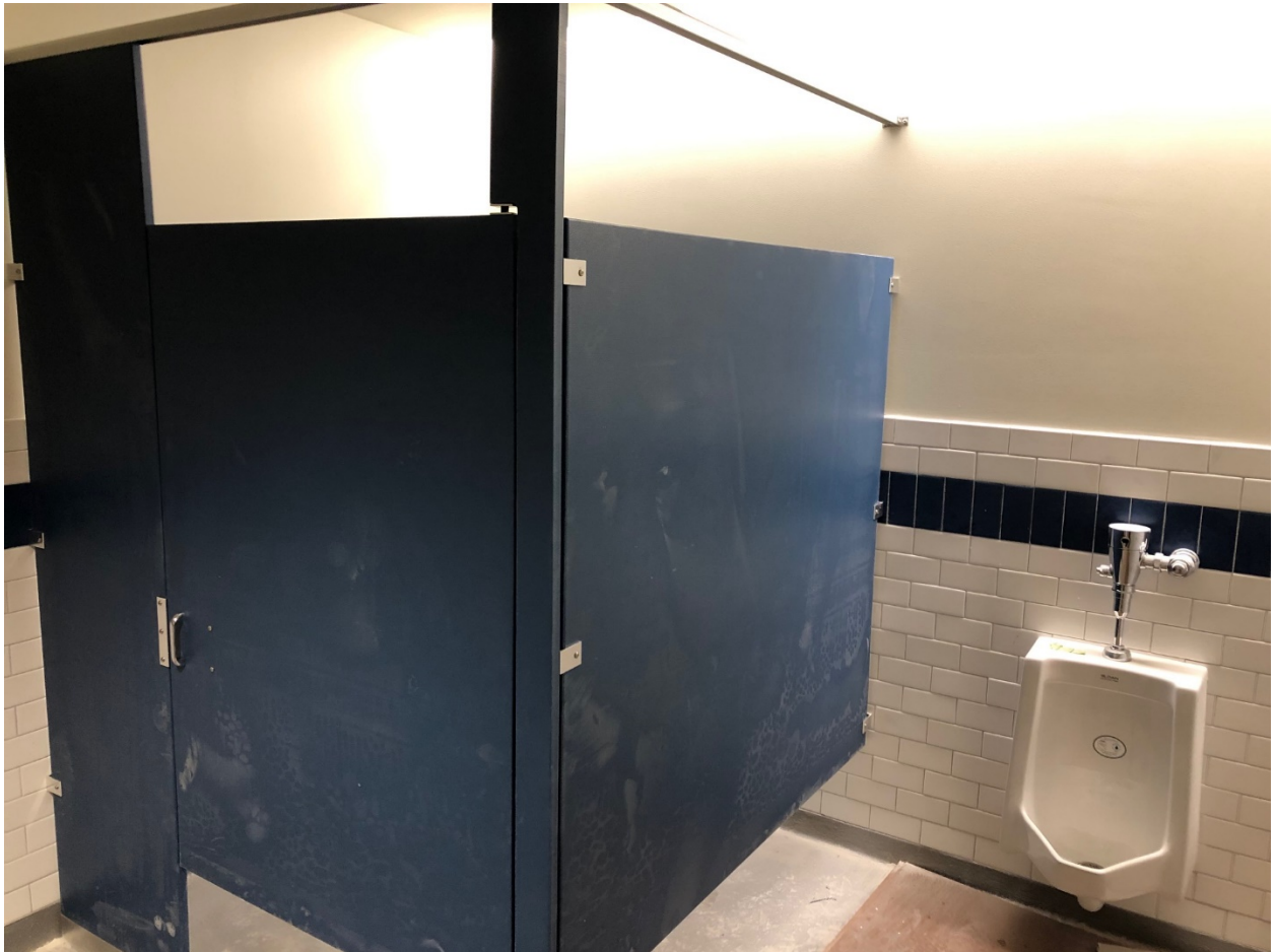
División de los baños – 28-12-18
