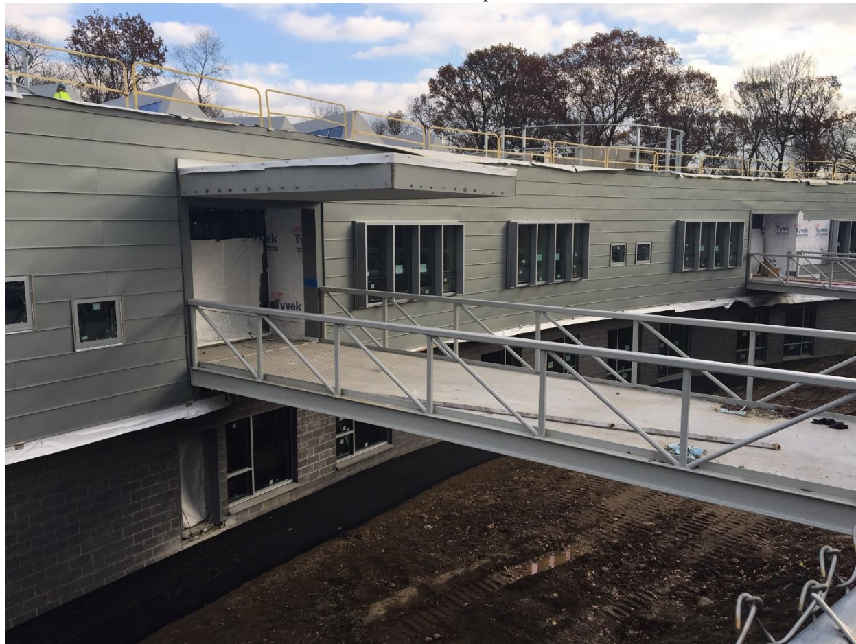
Fachada Oeste del edificio con puentes – 11/21/18
