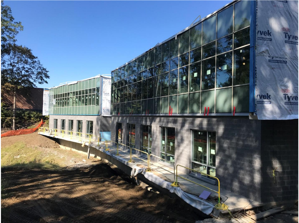
Fachada sur del edificio – 17 de octubre de 2018
