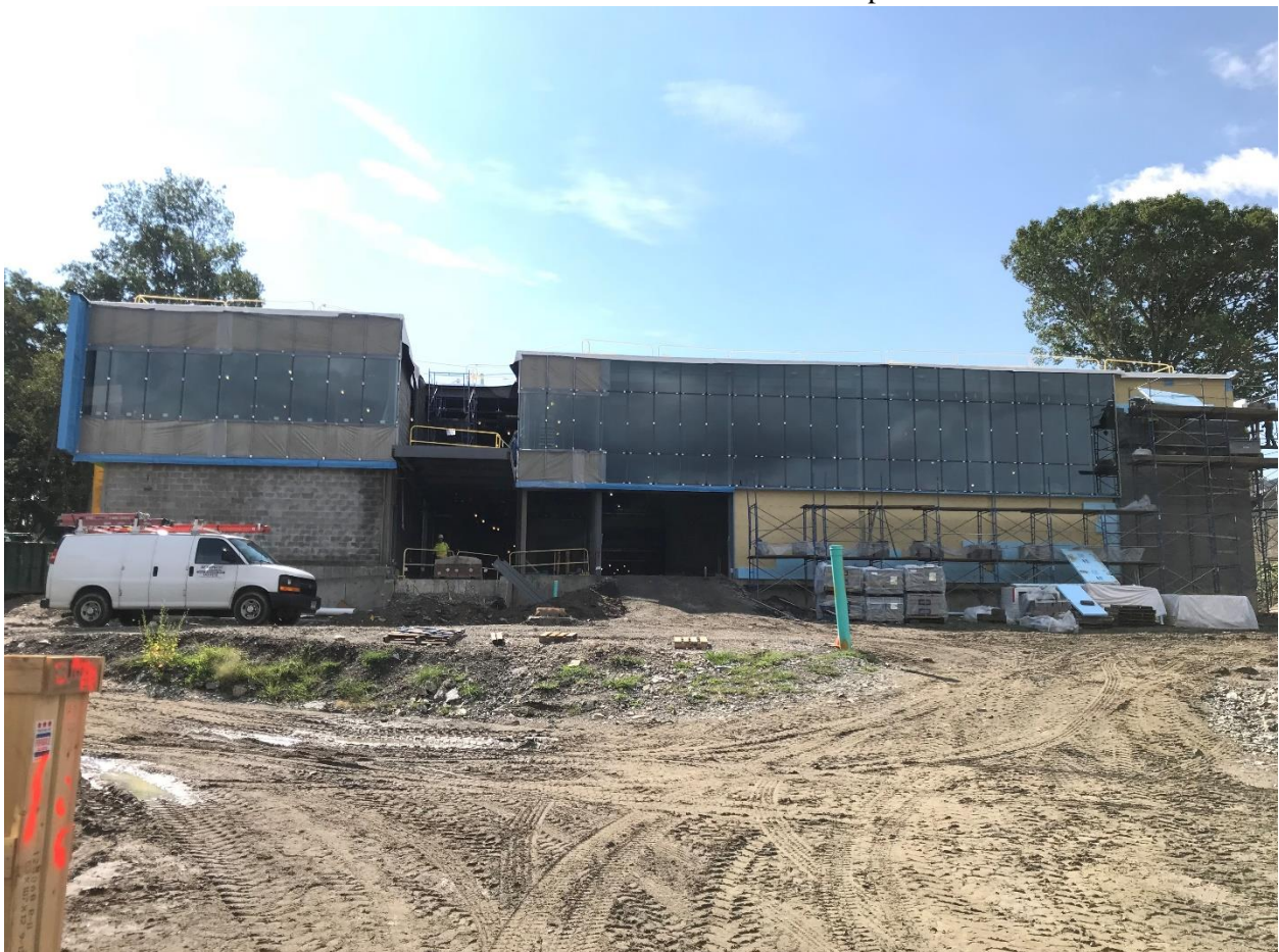
Fachada de la cara norte del edificio tomada el 19 de septiembre de 2018
