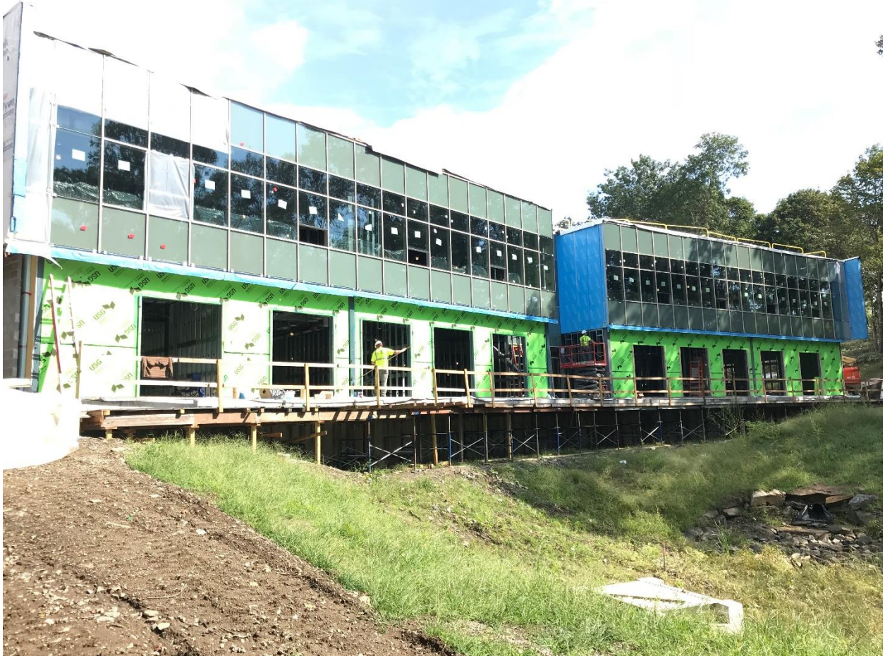
Fachada de la cara sur del edificio tomada el 19 de septiembre de 2018
